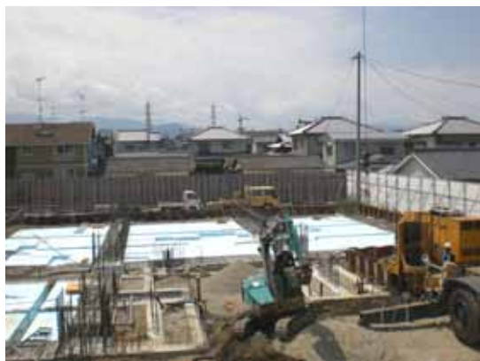
<工事現況…平成20年7月28日撮影>
